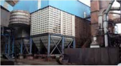
Erdemir Sinter Fabrikası Hammadde Toz Toplama Sistemi Modernizasyonu
