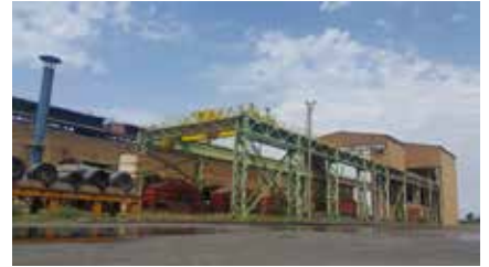
İsdemir Skala Kırma Tesisinin Uzatılması
