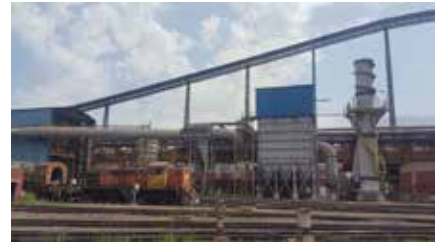
İsdemir Yüksek Fırınlarda Kükürt Giderme Tesisi Toz Toplama Sisteminin Yenilenmesi
